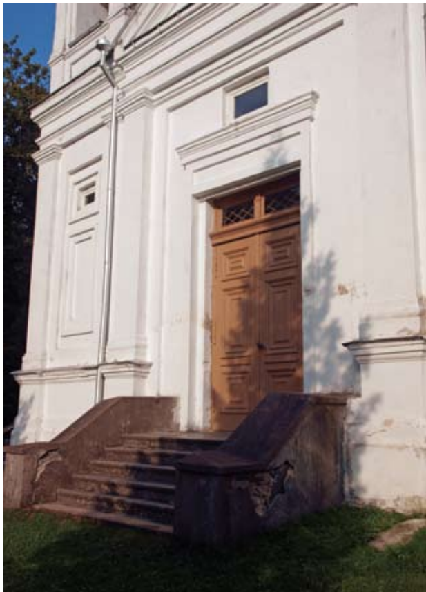
3. Wejście do kościoła.
