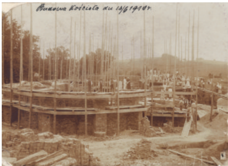
Il. 1. Budowa kościoła w Futomie, fot. z 1910 r.
