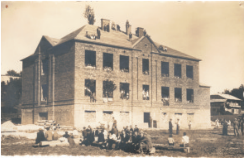
Il. 3. Budowa szkoły podstawowej w Futomie, fot. z 1951 r.
