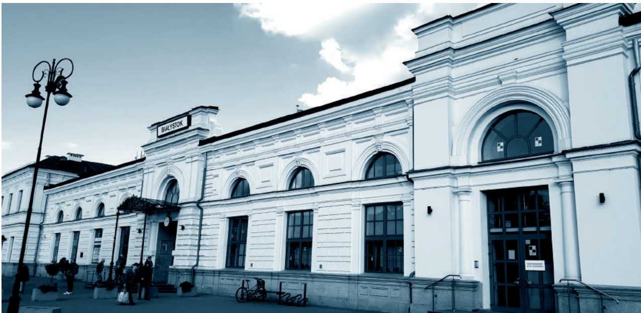
Dworzec kolejowy w Białymstoku. Tu przyjeżdżał i stąd odjeżdżał pociąg z i do Warszawy
