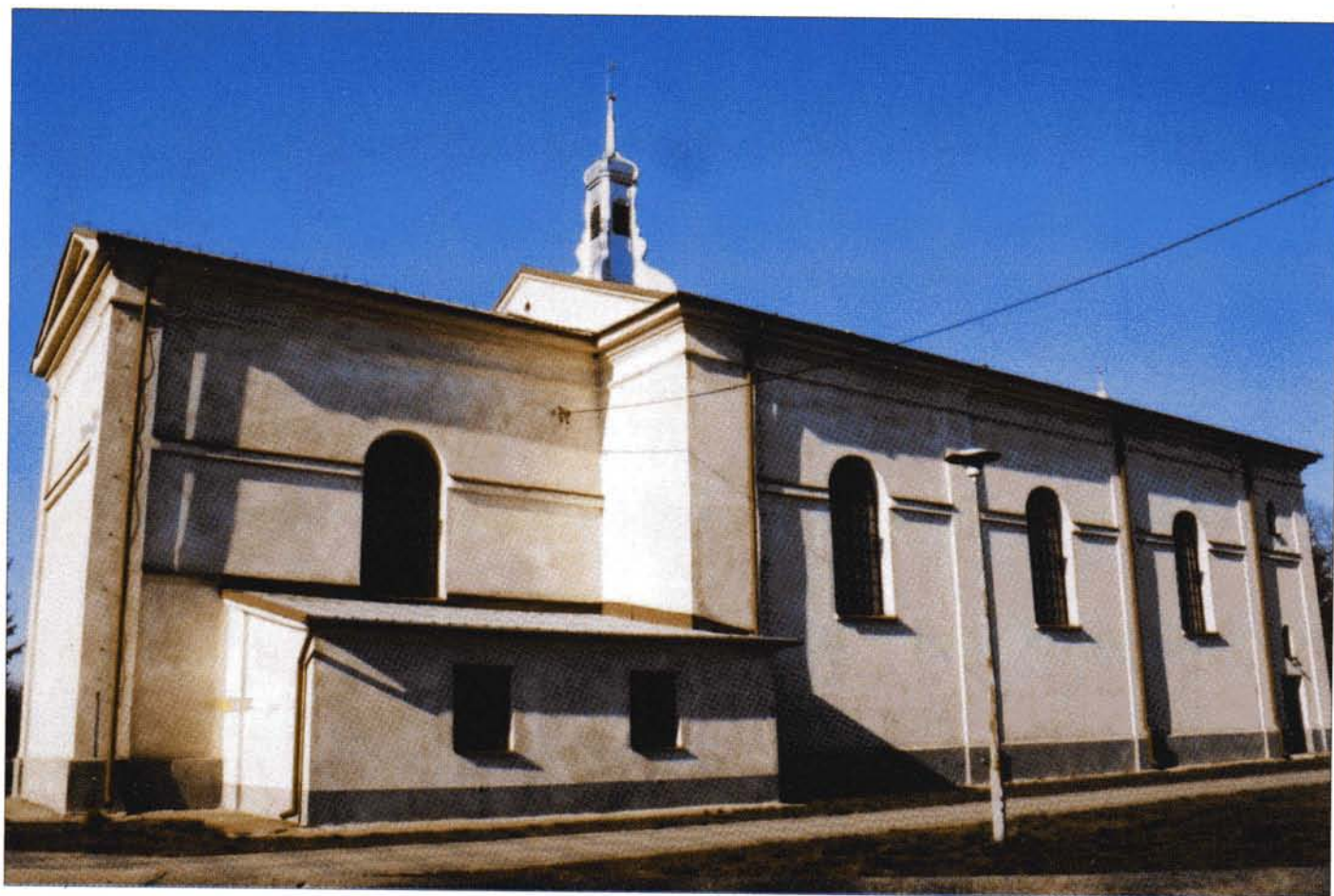
32. Dąbrówka Kościelna. Kościół parafialny p.w. św. Anny, zbudowany w 1875 r. wg proj. L. Marconiego i S. Kucharzewskiego. Fot. Maria Maroszek, 2004 r.
