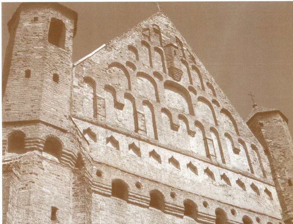
Sinkovičiai. Šv. Mykolo cerkvė, statyta XVI a. pr. Gotikinė gynybinė architektūra. Viršutinė dalis. A. Aljakseeŭ, A. Lukaševič, Spadčyna Belarusi, Minsk 2005, s. 197.
