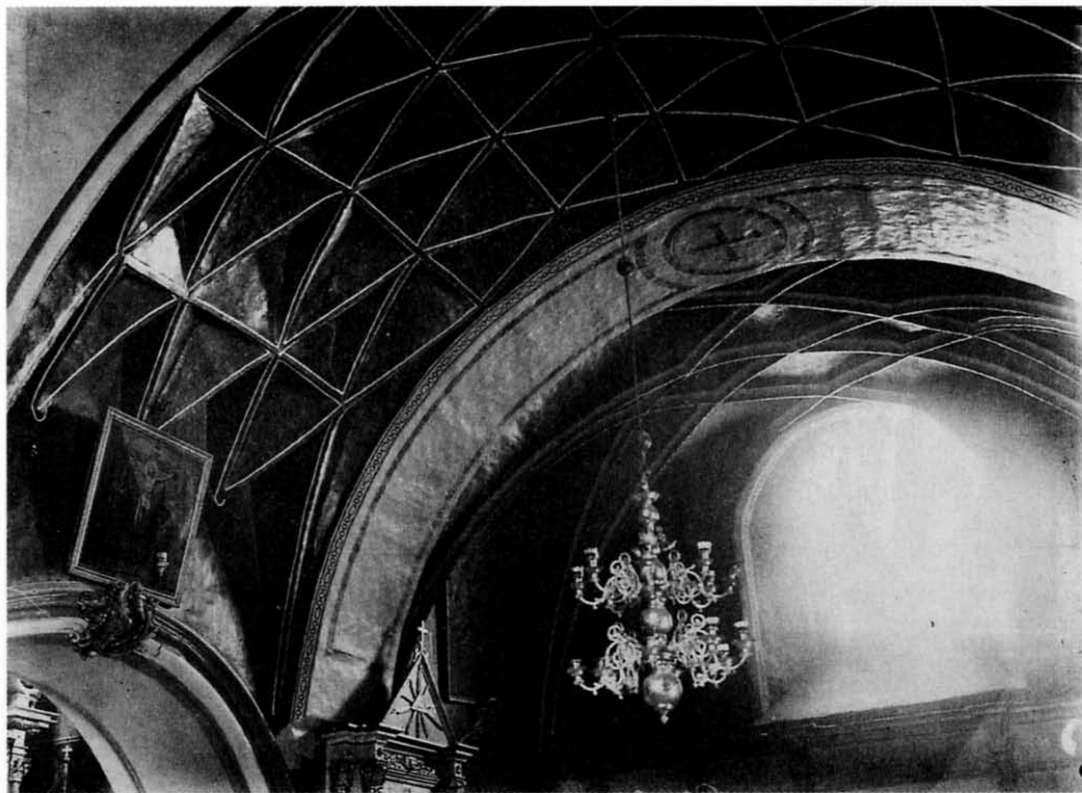
Sklepienia kryształowe i sieciowe, gotyckie z pocz. XVI w. w cerkwi Zwiastowania NMP.
