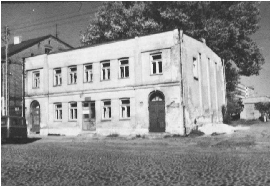
1. Budynek synagogi przy ul. Pięknej 3, 1978 r. (Wojewódzki Urząd Ochrony Zabytków w Białymstoku, fot. A. Juszczyk)
