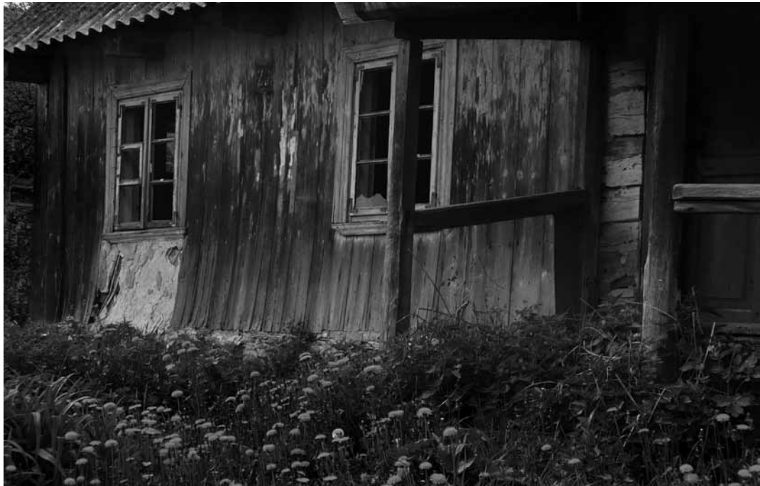
Stary, opuszczony dom w Krynkach
