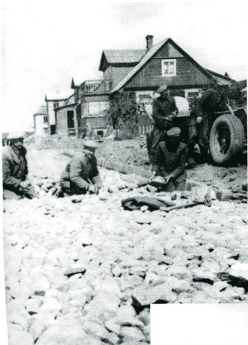
Mońki 1959 r. budowa ul. Tysiąclecia
