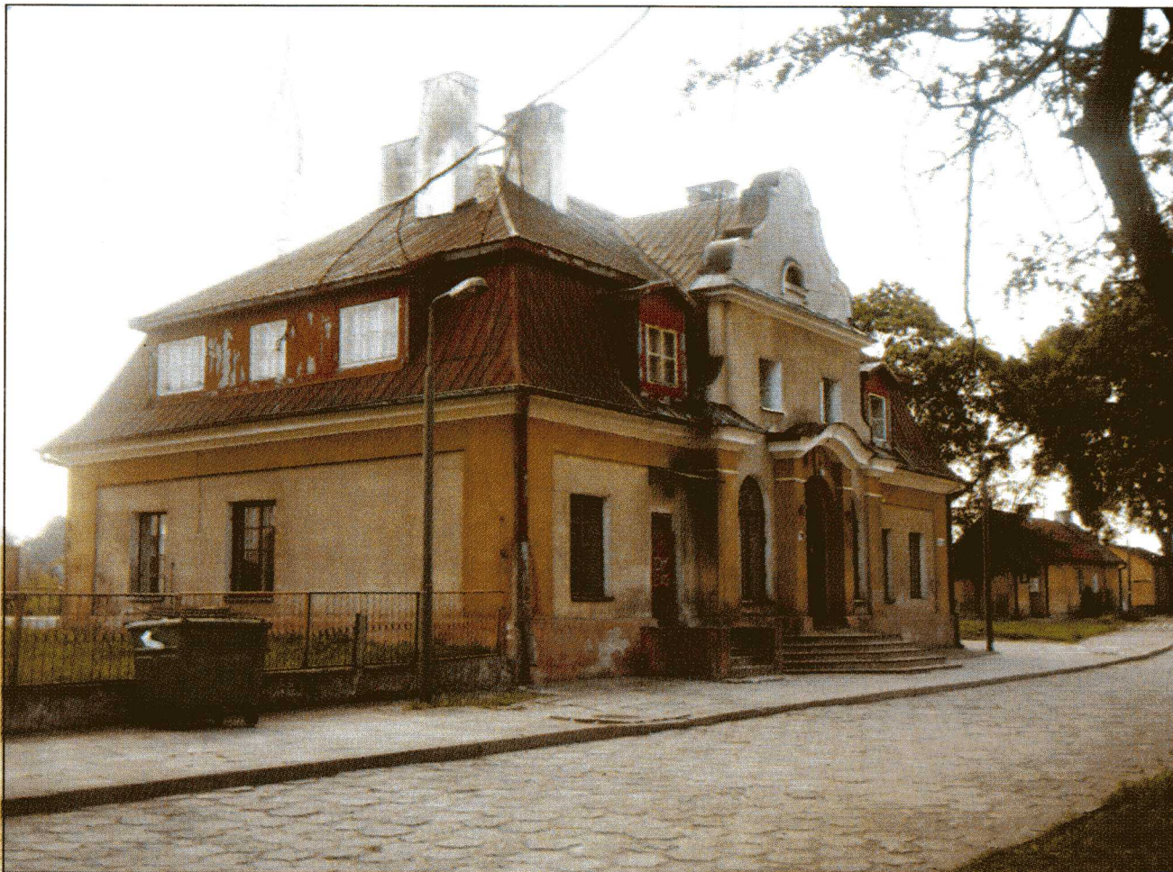
Mońki, budynek stacji kolejowej z lat 30-ych XX w.
