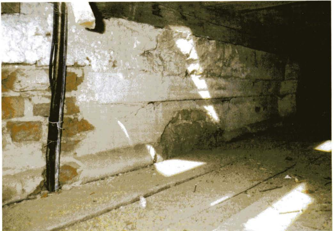
Oryginalny strop kościoła parafialnego w Jasionówce
