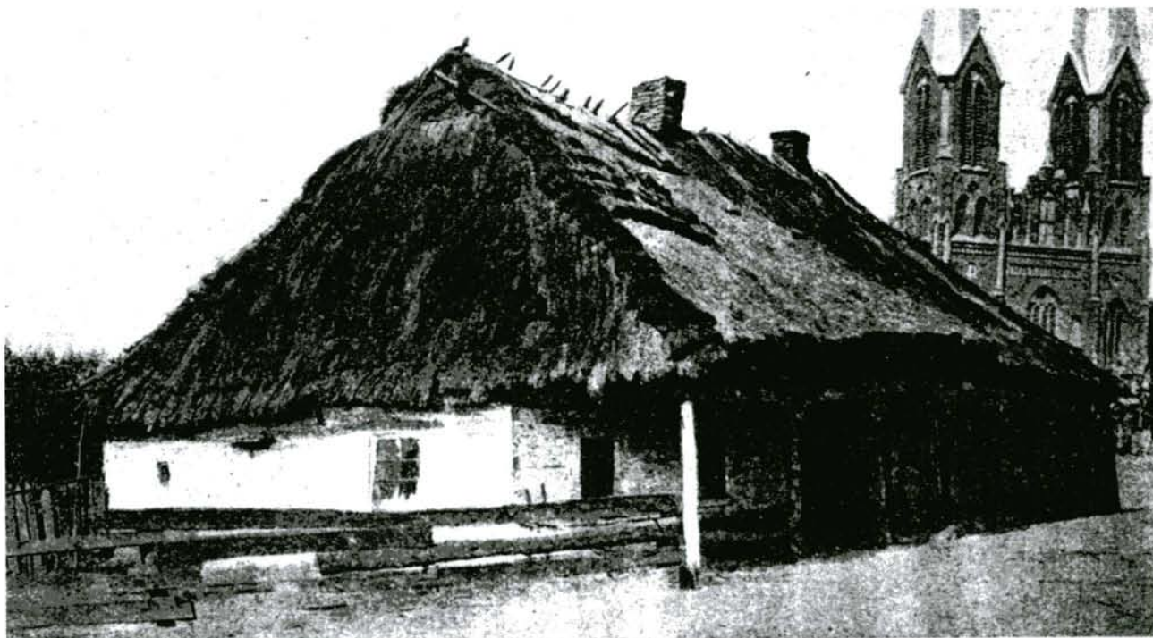
Kobylin. Gospoda proboszczowska. Fot. Teofil Pycz. Pocz. XX w. Z. Gloger, Budownictwo drzewne , t. 2, s. 84.
