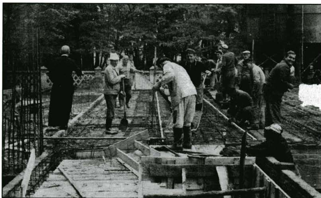
Ilustracja 14: Chodaków 1982 r. Prace przy budowie nowego kościoła; szalowanie stropu dolnej świątyni.
