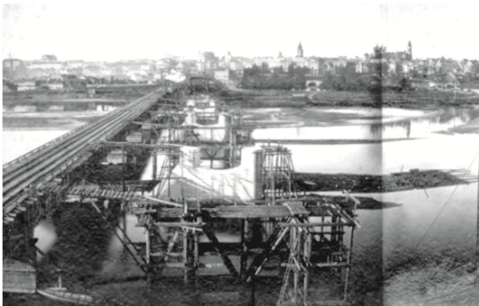
Budowa mostu Kierbedzia w Warszawie (1863)
