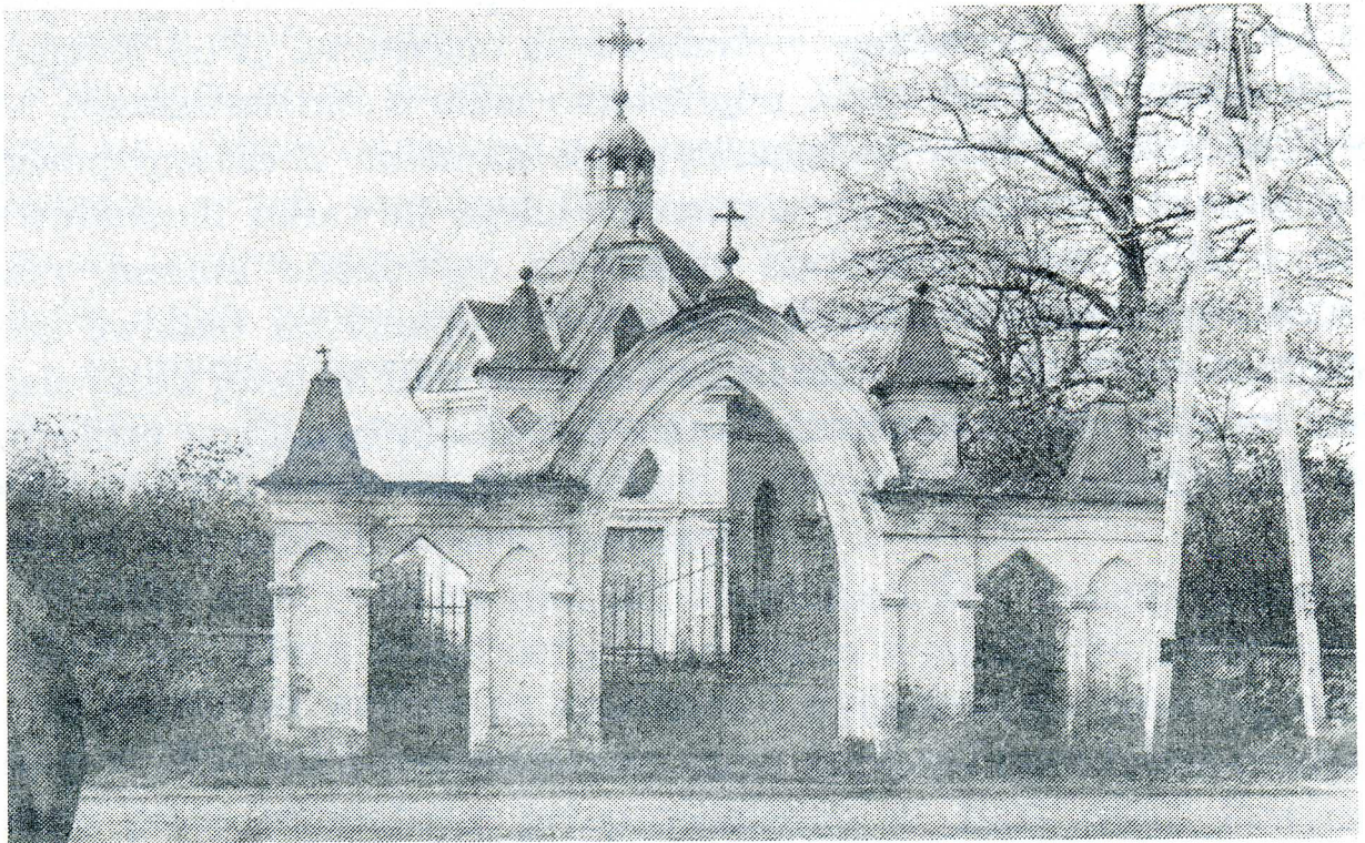
Rys. 9. Zabłudów, Kaplica Św. Rocha; fot. Z. Minko
