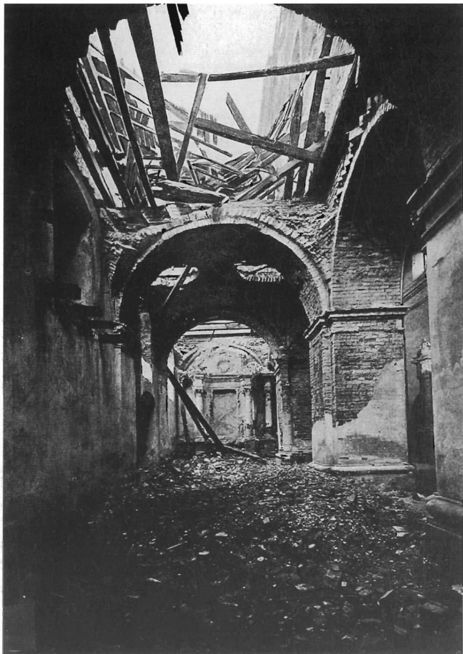
18. Drohiczyn. Kościół pw. Wniebowzięcia NMP pofranciszkański z ok. 1682-1715. Wnętrze nawa boczna. Fot. Zygmunt Gloger (?) 1903 r. Z.Gloger, Dolinami rzek , Warszawa 1903.
