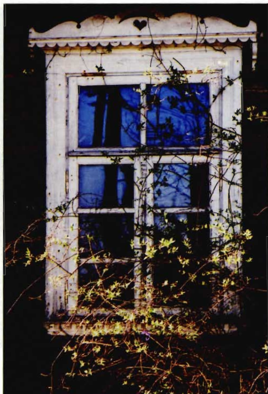
Dolistowo Stare. Dom mieszkalny nr 12. Rok budowy 1919. Szczegół okna. (6.05.2003)
