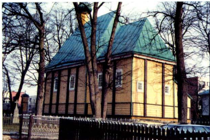
Bielsk Podlaski, woj. białostockie - Cerkiew Narodzenia NMP. Widok na część ołtarzową. Fot. Jarosław Kłoz, kwiecień 1996 Kolekcja ROSiOŚK w Białymstoku
