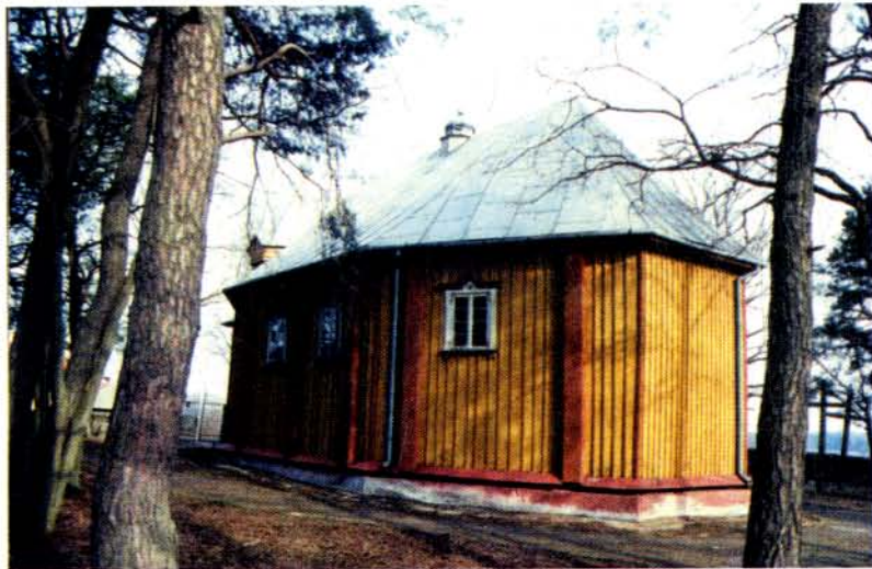
Żurobice, woj. białostockie - Cerkiew św. Dymitra, dawniej unicka, obecnie prawosławna, typowy przykład unickiego budownictwa cerkiewnego z XVIII wiek: drewniana, konstrukcji zrębowej, na rzucie sześcioboku, z sygnaturką na dachu.
