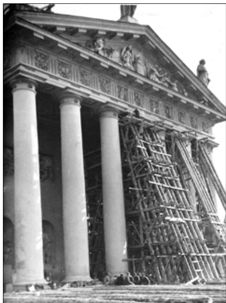
23. Stemplowanie zabezpieczające portyk Bazyliki Wileńskiej przy późniejszym rąbaniu szybków w fundamencie i podziemiu bazyliki, stan z 1932
