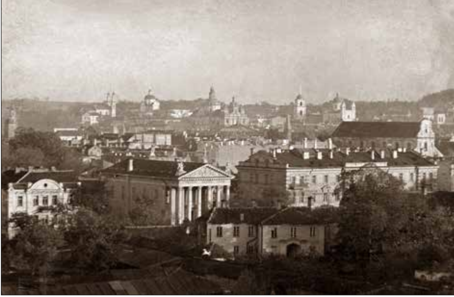
1. Widok ogólny Wilna, fot. Jan Bułhak, przed 1930 (Polona)
