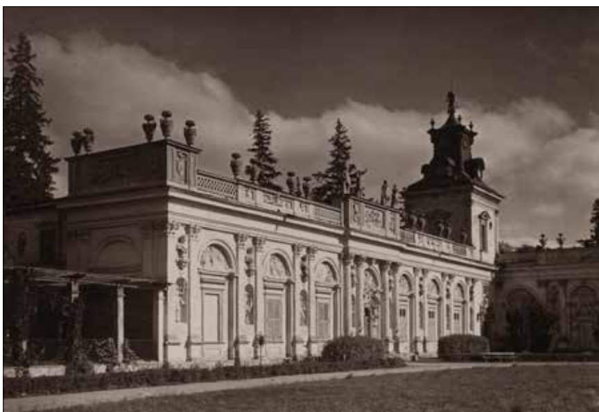
12. Wilanów, pałac – skrzydło, fot. Jan Bułhak, 1930 (Polona)
