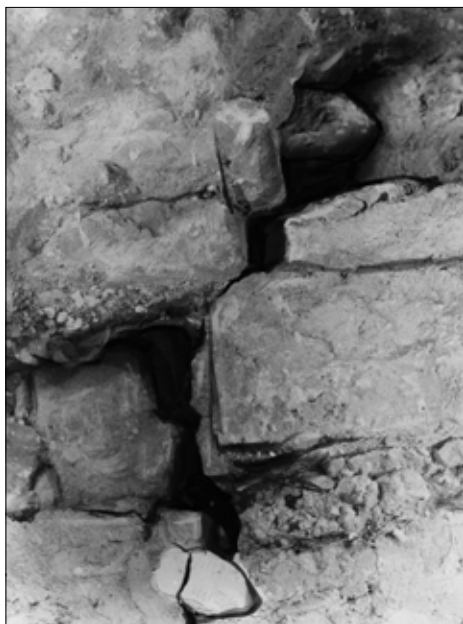
24. Fragment muru Bazyliki z widocznym pęknięciem, 1932 (Narodowe Archiwum Cyfrowe)
