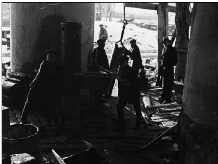
25. Wykonywanie prac żelbetonowych przy wzmacnianiu portyku Bazyliki Wileńskiej, z prawej strony w kapeluszu inż. Jan Peksza, 1932 (Narodowe Archiwum Cyfrowe)
