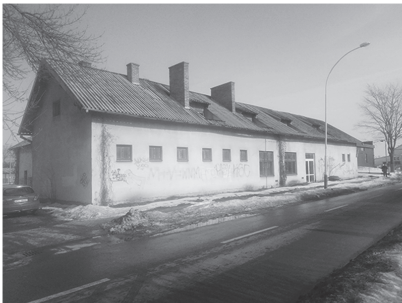
Il. 13. Budynek świetlicy kolejowej, ul. Lubomirskich, Przeworsk 2021. Fot. K. Ignas
