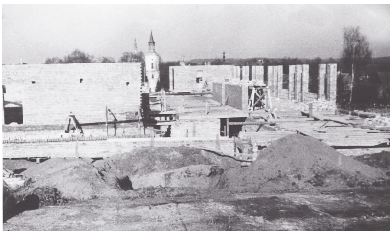
Il. 5. Budowa siedziby Szkoły Podstawowej w Supraślu, początek lat 60. XX w.
