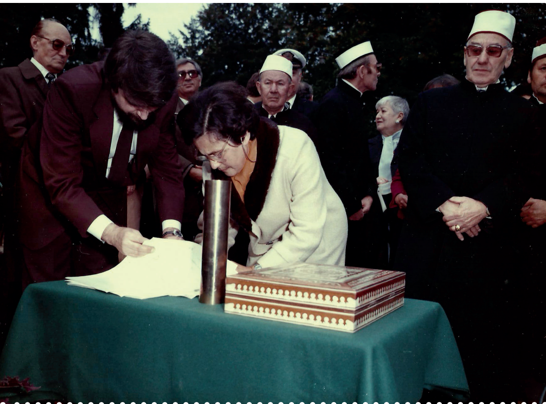
Przewodniczaca MGW w Gdańsku Dżemila Smajkiewicz-Murman podpisuje akt erekcyjny budowanego meczetu przed jego wmurowaniem
