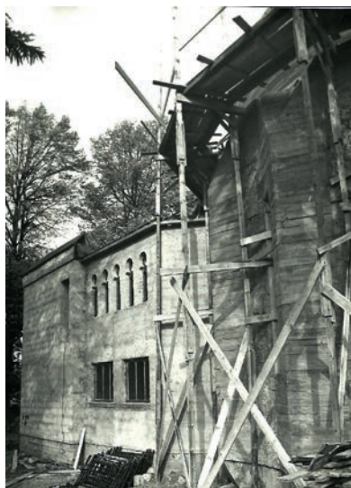
Meczet w trakcie budowy
