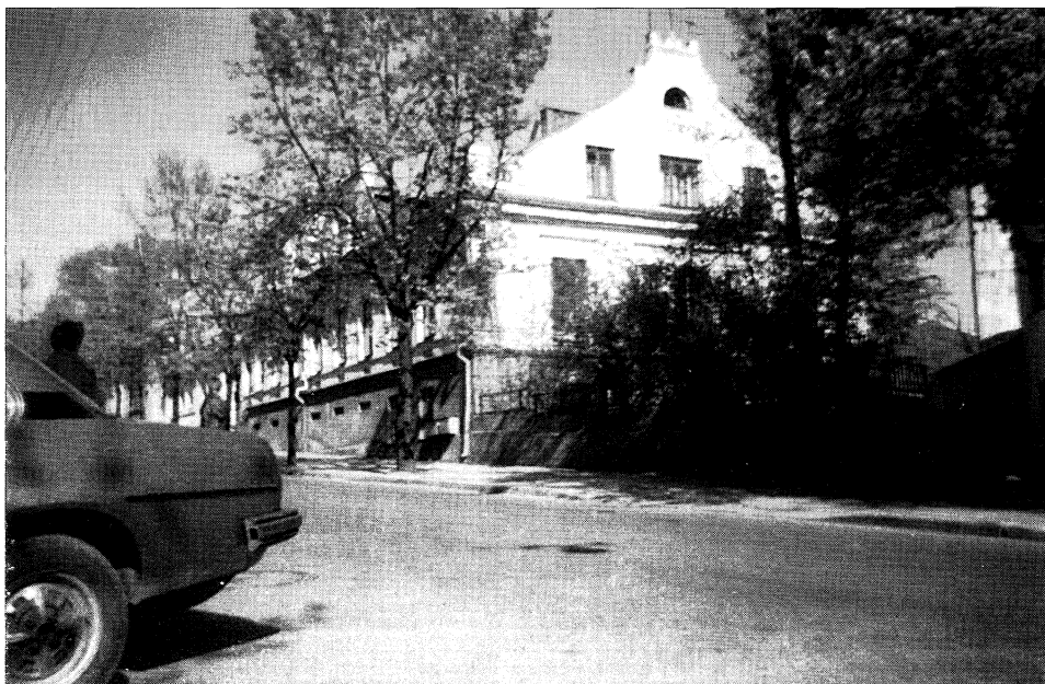
42. Dawny budynek „Omegi” – stan obecny.
