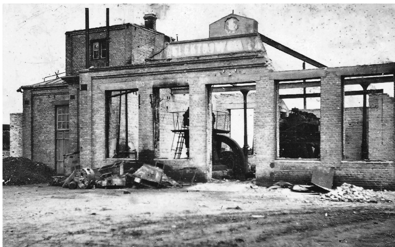
Il. 16. Wysadzony w powietrze budynek elektrowni miejskiej (istnieje). Rok 1944. Autor: Witold Żółkowski. Źródło: Zbiory rodziny Autora
