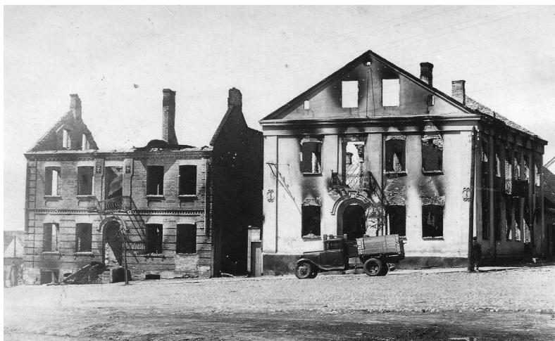
Il. 10. Spalone przez Niemców kamienice przy rynku: po lewej Oljana, po prawej Mostowlańskiego (nie istnieją). Rok 1944. Autor: Witold Żółkowski. Źródło: Zbiory rodziny Autora
