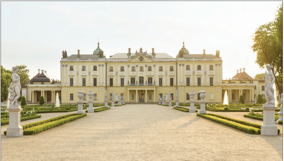
Pałac Branickich w Białymstoku, widok od strony ogrodu. Początki w XVI wieku. Przebudowa w XVII w.
