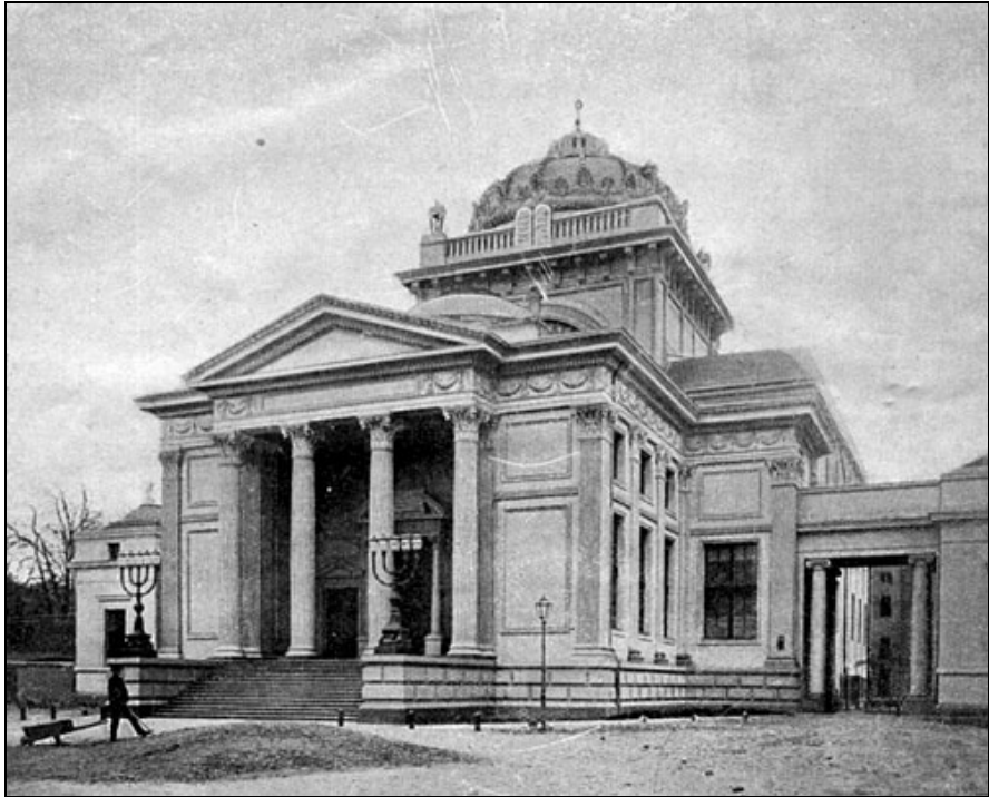
Wielka Synagoga w Warszawie, Tłomackie 7, 1878
