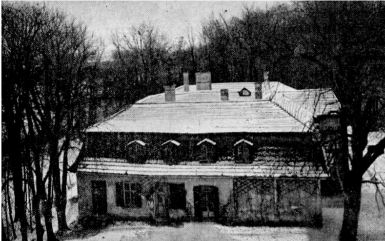
Il. 5a. Dwór w Rogowie, Widok zewnętrzny, źródło: T. Szydłowski, Dwór w Rogowie. Zabytek budownictwa drewnianego XVII wieku , Kraków 1918
