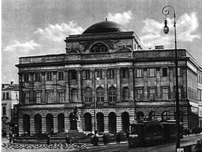
Pałac Staszica w Warszawie, 1820–1823; projekt Antonia Corazziego, rewaloryzowany 1924–1926 według projektu Mariana Lalewicza, zniszczony w 1944, odbudowany: 1947–1950 według projektu Piotra Biegańskiego. Siedziba Polskiej Akademii Nauk i Towarzystwa Naukowego Warszawskiego
