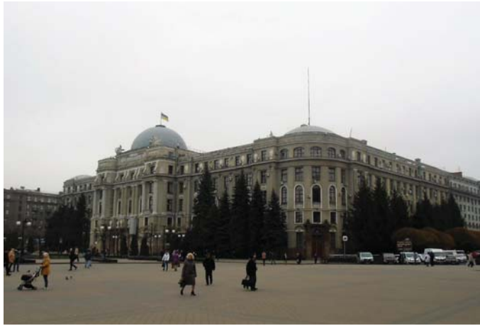
Ilustr. nr 8. Budynek Kolei Południowej w Charkowie 35
