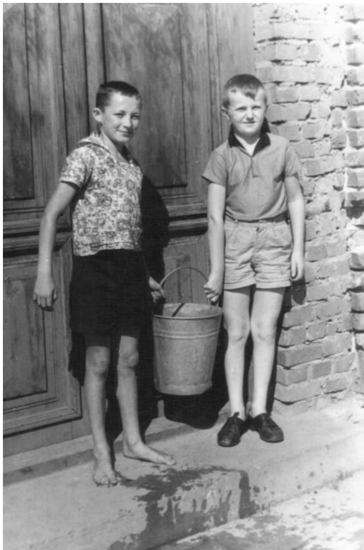
Il. 1. Noszenie wody ze studni do domu było kiedyś codziennością
