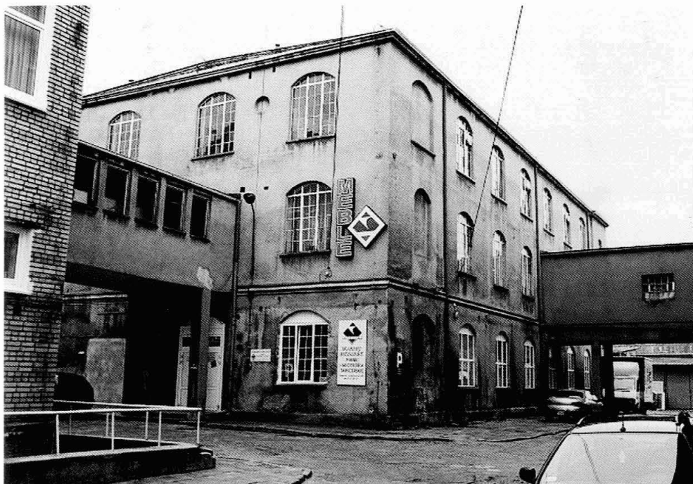
24. Elewacja północno- i południowo-zachodnia dawnej tkalni z widocznymi łącznikami i obniżonym płaskim dachem. Fot. S. Wicher, XI 2010 r. North- and south-western elevation of the former weaving mill with visible connectors and lowered flat roof. Photo: S. Wicher, November 2010.
