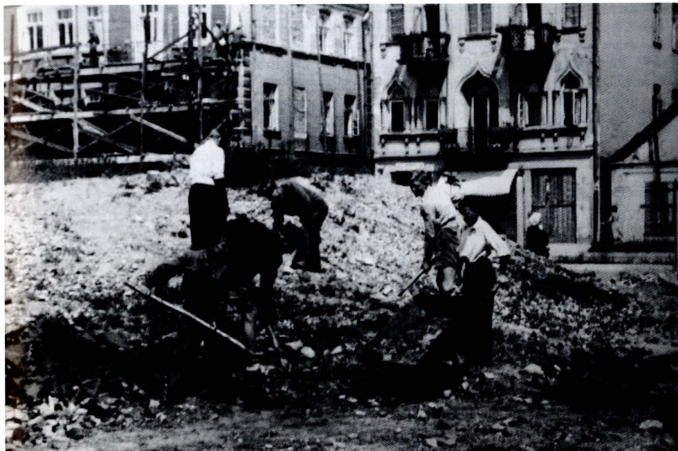
14. Odgruzowywanie miasta w latach 50. XX w. przez uczniów Technikum Mechanicznego w Białymstoku - w tle domy przy ul. Lipowej 28 i 30. Zdjęcie w posiadaniu właściciela domu przy ul. Lipowej 28. Clearing the town of rubble during the 1950s by pupils of the Secondary Technical School in Białystok - in the background: houses in 28 and 30 Lipowa Street. Photo: property of the owner of the house in 28 Lipowa Street.
