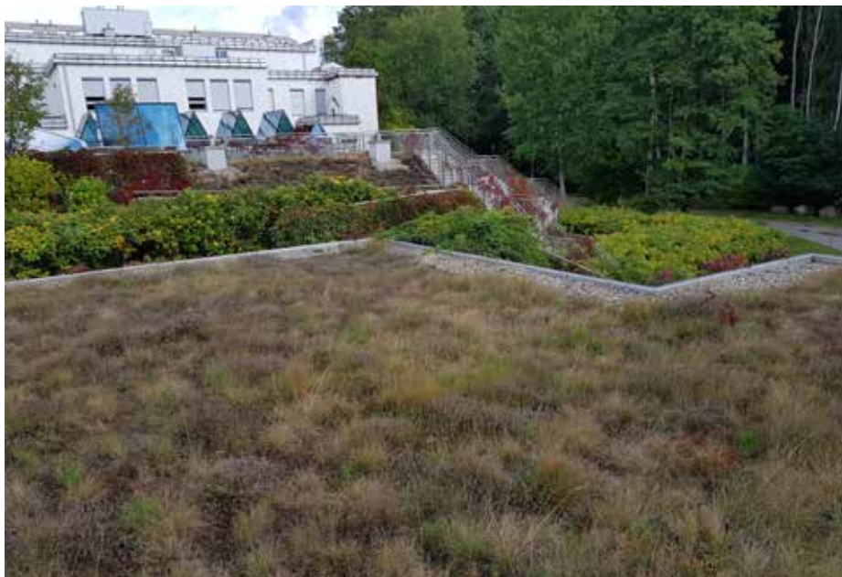
Fot. 115. Murawa kserotermiczna na dachu kampusu Uniwersytetu w Białymstoku.
