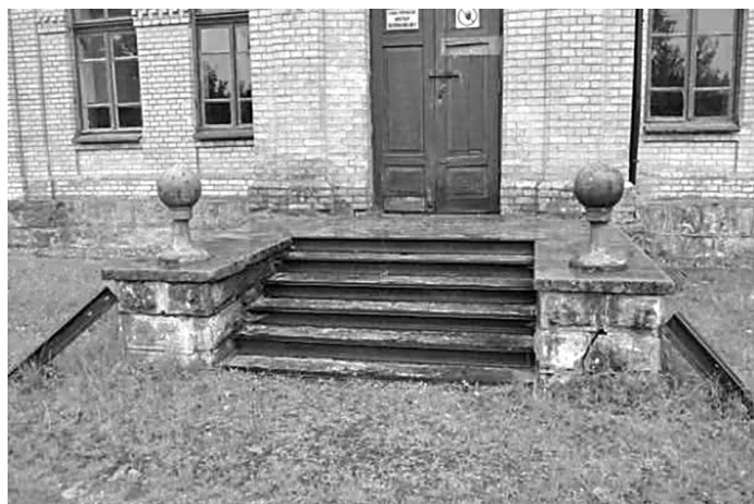
II. 16. Schody prowadzące do głównego wejścia dworca w Kamiennej Nowej. Stan na rok 2021, fot. autorzy
