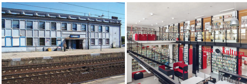
Il. 22. Dworzec w Rumii – stan przed remontem i po remoncie ( https://kurier-kolejowy.pl/aktualnosci/14160/dworzec-w-rumii-przejdzie-remont.html ; https://architektura.muratorplus.pl/zycie-w-architekturze/2015/stacja-kultura-dworzec-w-rumi-rewitalizacja-i-adaptacja-zaniedbanych-wnetrz-dworca-na-cele-kulturalne/1150/ /dostęp: 30.11.2022/)
