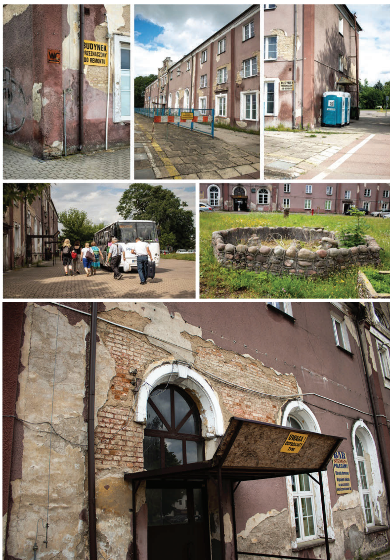
Il. 10. Dworzec w Sokółce. Stan na rok 2022, fot. autorzy
