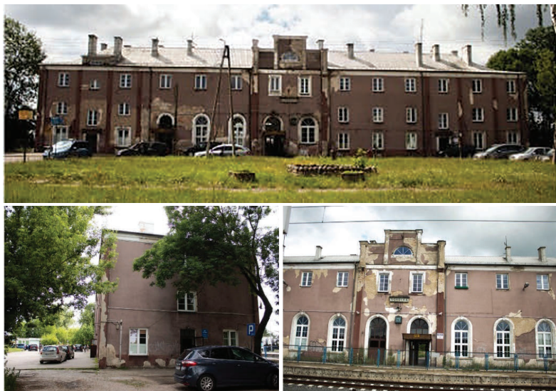
Il. 11. Dworzec w Sokółce. Stan na rok 2022, fot. autorzy
