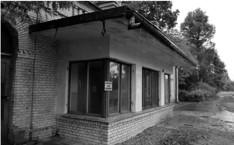
Il. 14. Zdjęcie z budowy nastawni w Kamiennej Nowej ok. 1960 r. oraz stan na rok 2021, źródło: z archiwum Marcina Rebut-Stankiewicza oraz autorzy
