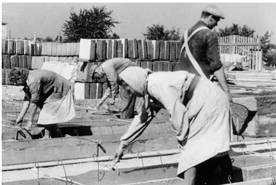
2. Kobiety pracujące przy budowie szybkościowca w Warszawie (wg Słownika języka polskiego PWN szybkościowiec to „budynek, którego budowa trwała rekordowo krótko”). Źródło: Odbudowa Warszawy. Budowa szybkościowca (PKF 38/49).
