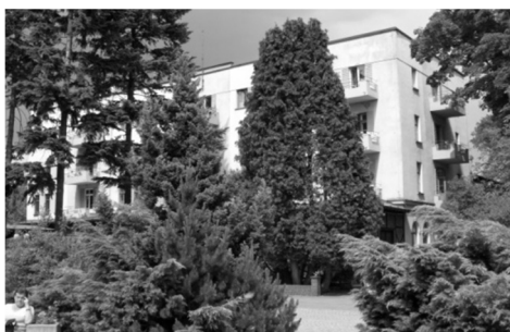
Fotografia 11. Goczałkowice-Zdrój, Sanatorium Rehabilitacyjne dla Dorosłych, ul. Uzdrawiskowa 54 – jeden z pawilonów
